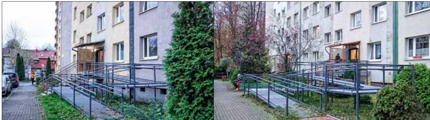
Powyżej nowe podjazdy powstałe na Giszowcu. Ułatwiają dotarcie do drzwi wejściowych budynków przy ul. Wojciecha 40b oraz Wojciecha 47.
