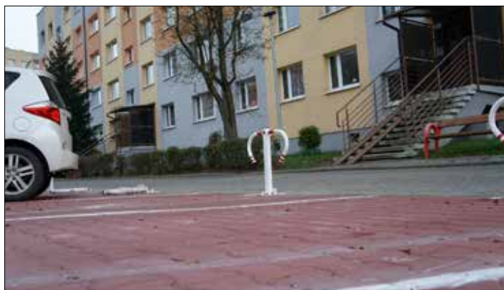
Giszowiec – przy ul. Wojciecha 39, 39a, 39b miejsca parkingowe uzyskały nową nawierzchnię z kostki brukowej
