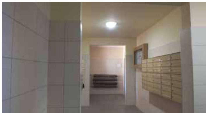
Wchodząc do budynku przy Józefowskiej 98 wita nas taki widok parteru
