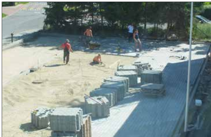
Przed domem wykonywany jest parking
