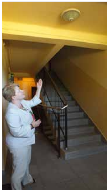
Wnętrze klatki schodowej domu przy ul. Jabłoniowej 54 pokazuje kierowniczka administracji osiedla Ewa Domagała
