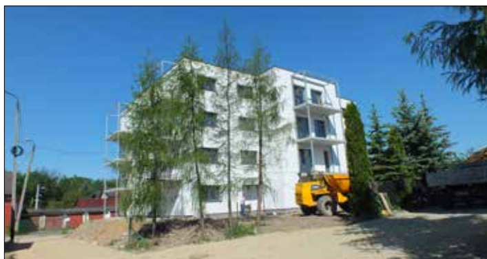
Budowa domu przy ul. Domeyki 12 w osiedlu Murcki jest już na finiszu
