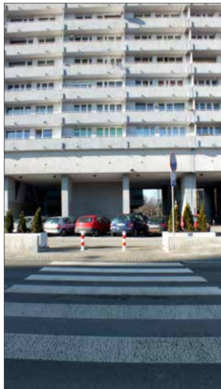
A dalej oznaczone zebra przejście przez Śródmiejską kończy się na słupkach, za którymi jest parking, więc ciąg pieszy w tym miejscu po prostu... znika
