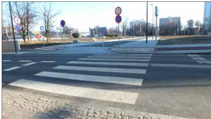
Od strony alei Korfante go prowadzi chodnik, zakończony przejściem (zebra) przez Śródmiejską, ale co dalej?
