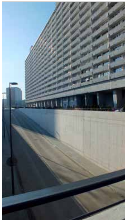
Śródmiejska od północy ku południowej stronie - po ostrym łuku w prawo i przejściu pod wiaduktem (który u góry nie jest drogą, ale placem - miejscem do zawracania) wspina się pod górkę
