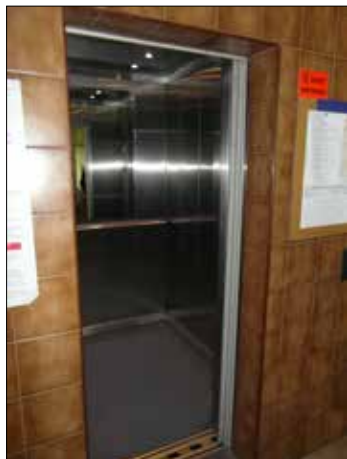
Po modernizacji – podwyższona kabina windy
